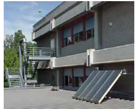
Istituto di Istruzione Superiore "I. Calvi", Finale Emilia: costruzione di pannelli solari da parte degli alunni
