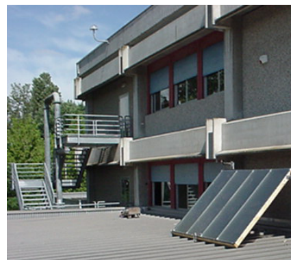
Istituto di Istruzione Superiore "I. Calvi", Finale Emilia: costruzione di pannelli solari da parte degli alunni
