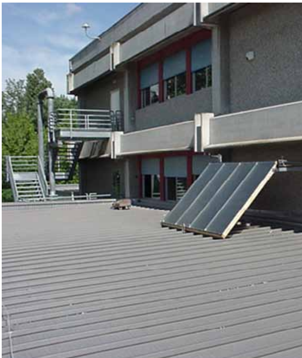
Istituto di Istruzione Superiore "I. Calvi", Finale Emilia: costruzione di pannelli solari da parte degli alunni
