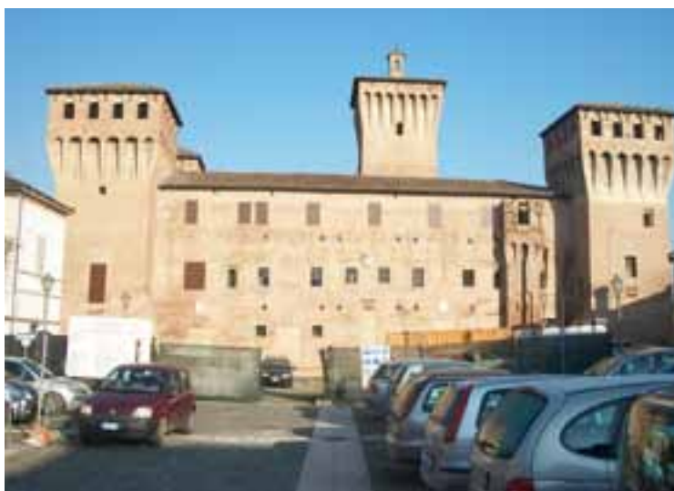
Dopo la ristrutturazione
